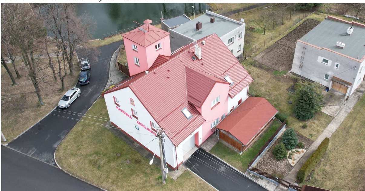
Obrázek č. 2.6.29: Hasičská zbrojnice – fotodokumentace z místního šetření
