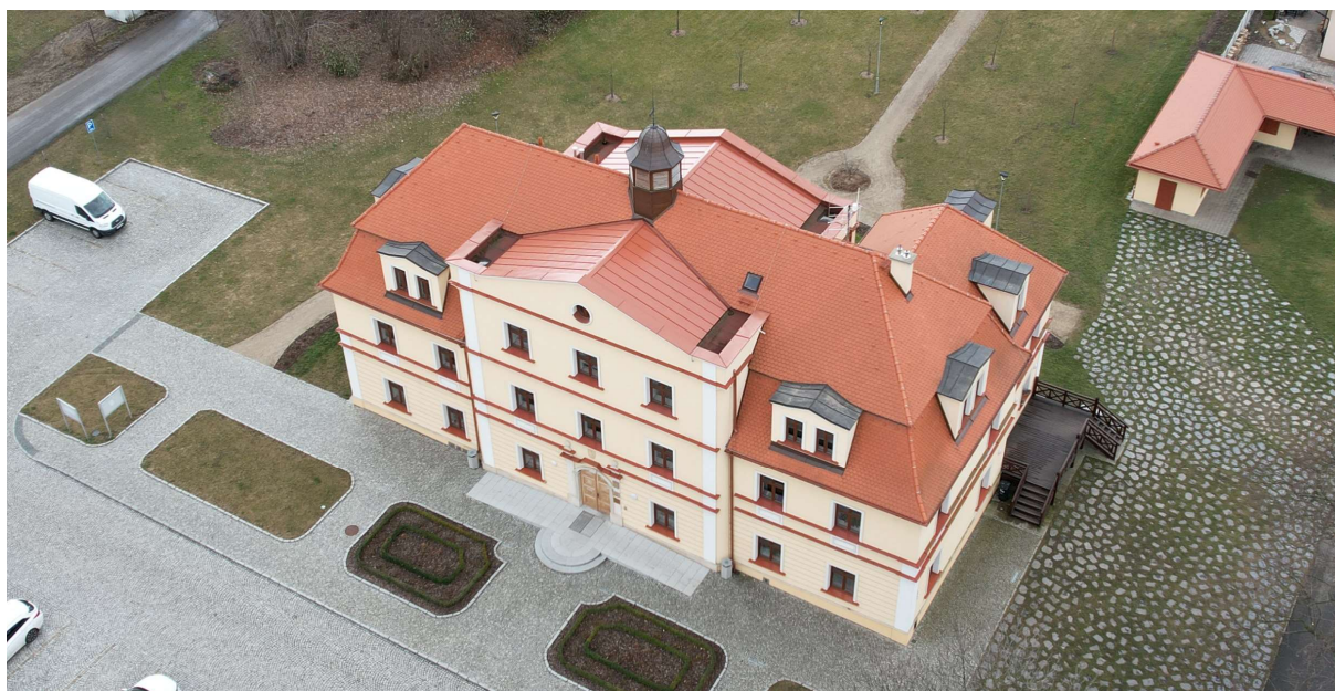
Obrázek č. 2.6.3: Zámecká budova – fotodokumentace z místního šetření
