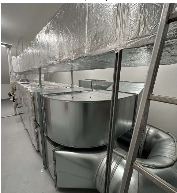
Obrázek č. 2.6.10: VZT kompaktní jednotka
