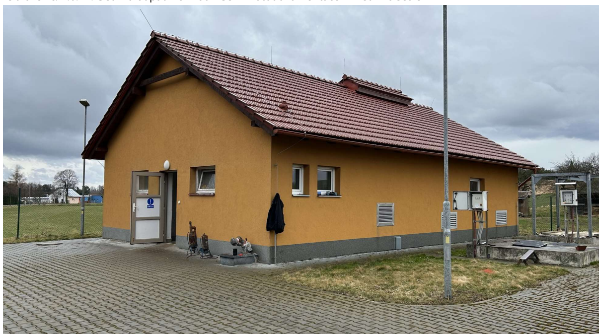
Obrázek č. 2.6.21: Čistírna odpadních vod - ČOV – fotodokumentace z místního šetření
