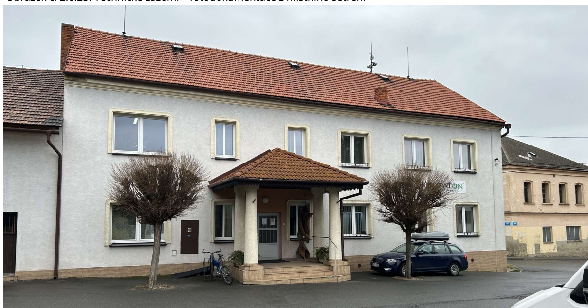
Obrázek č. 2.6.25: Technické zázemí – fotodokumentace z místního šetření
