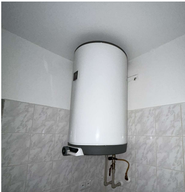
Obrázek č. 2.6.31: Zásobníkový ohřivač TV
