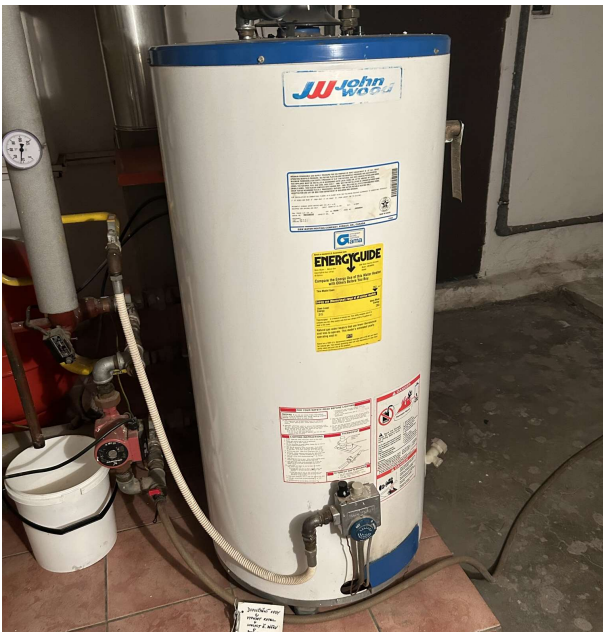
Obrázek č. 2.6.19: Zásobníkový ohřivač TV
