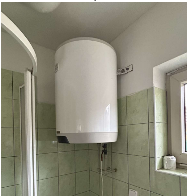
Obrázek č. 2.6.23: Zásobníkový ohříváč TV
