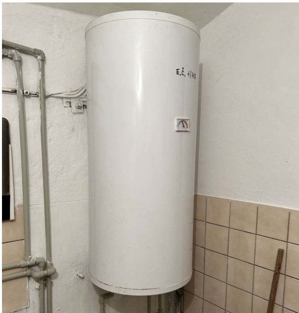
Obrázek č. 2.6.27: Zásobníkový ohřivač TV
